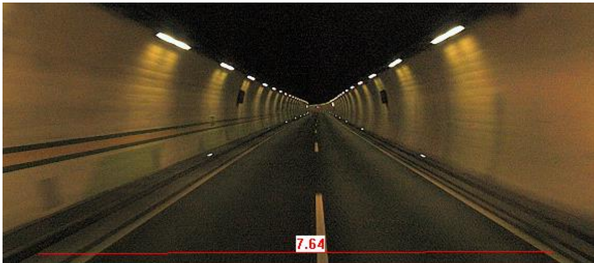
Typischer Tunnelquerschnitt N2+, km21.120
